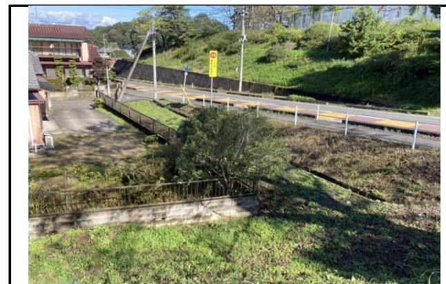
写真7 東側の側部 高台から側部下方を望む
