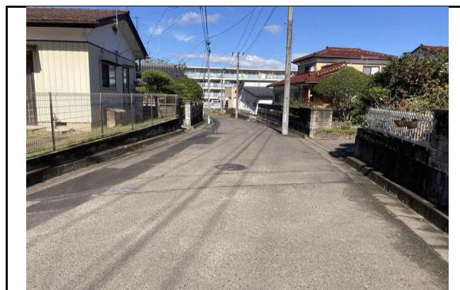
写真14 造成地中央 上方から下方を望む
