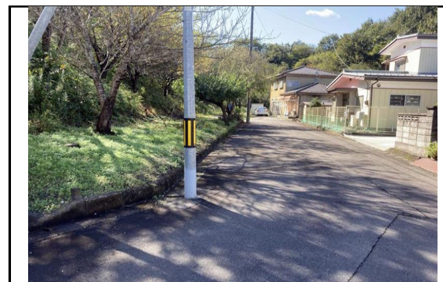
写真15 西側の側部 勾配は緩い
