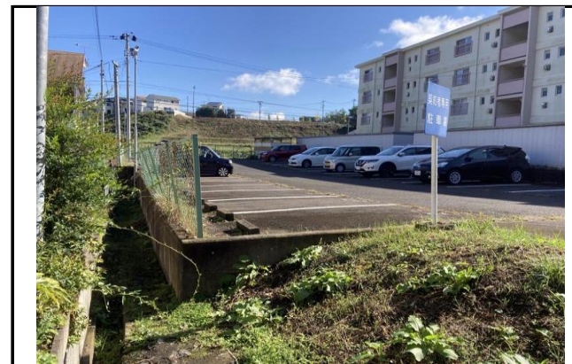
写真3 フェンスが傾いているが構造物に変状なし
