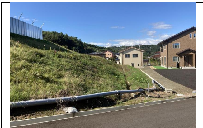
写真9 新規造成箇所 法面・排水工は適切
