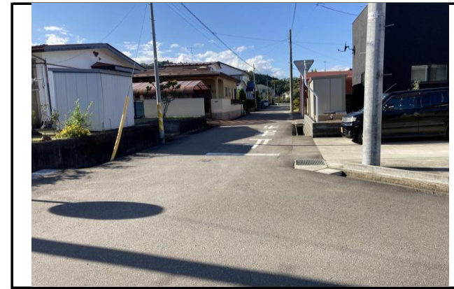
写真11 造成地中央 上方から下方を望む
