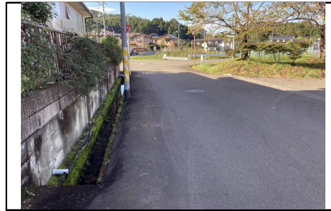
写真10 南側旧谷の末端付近 側溝に滞水
