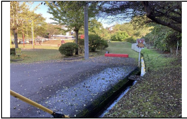
写真5 中央旧谷の頭部付近 側溝に豊富な流水
