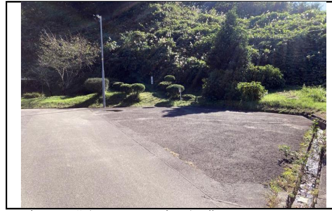
写真2 北側旧谷の頭部 側溝に湿り
