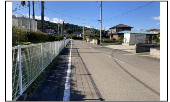
写真8 南側旧谷の側部 湧水・変状なし
