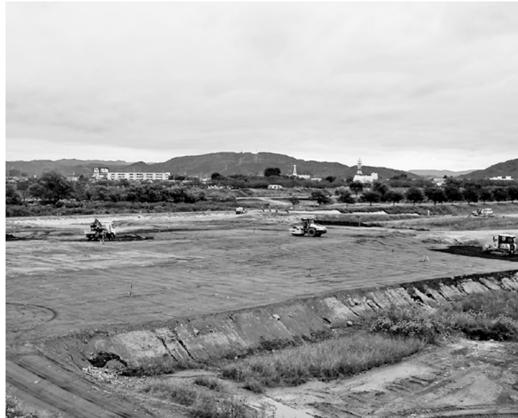
造成が進む白石川右岸河川敷整備事業
