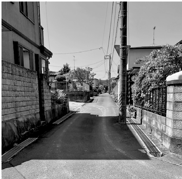
緊急車両 通行の支障となる電柱
