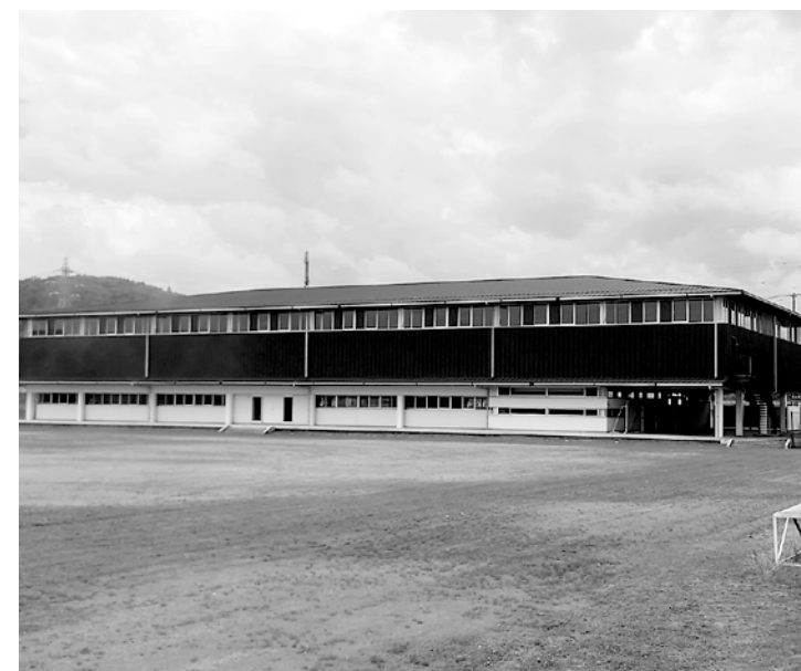
緊急時避難所利用の金ヶ瀬中学校体育館
